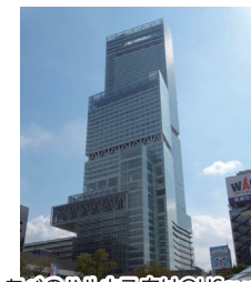
あべのハルカス向けeHSaver 「あべのハルカスの環境・設備計画と実施」 第55回 空気調和・衛生工学会 技術賞
