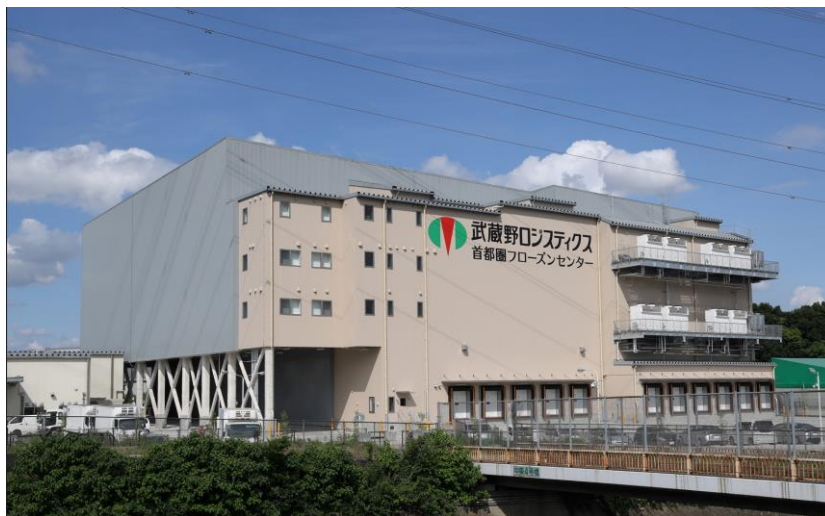
武蔵野ロジスティクスの大型冷凍倉庫「首都圏フリーズセンター」外観
