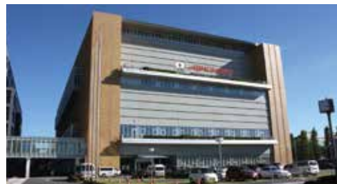
スポーツ施設
