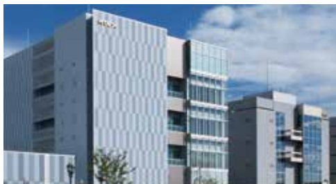
データセンター
