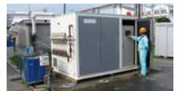
バイオレメディエーション工法
