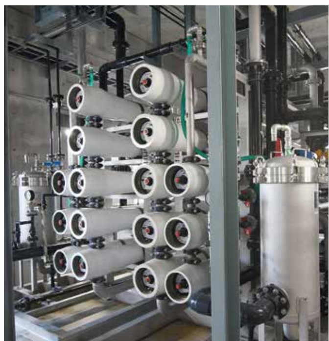
再生水設備(逆浸透膜ユニット)
