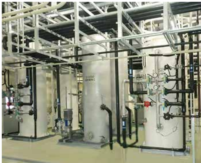
電子・半導体分野向け 純水製造設備(イオン交換方式)
