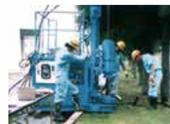
ボーリング調査
